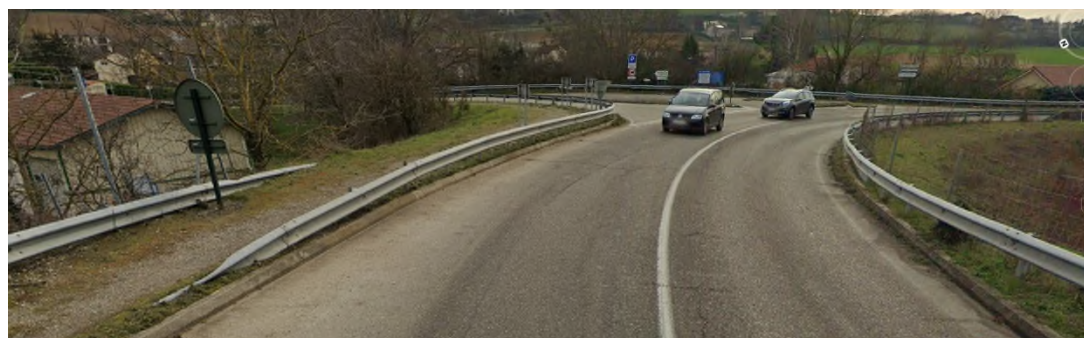
Figure 6: Photographies de la RD131 à l'état actuel
